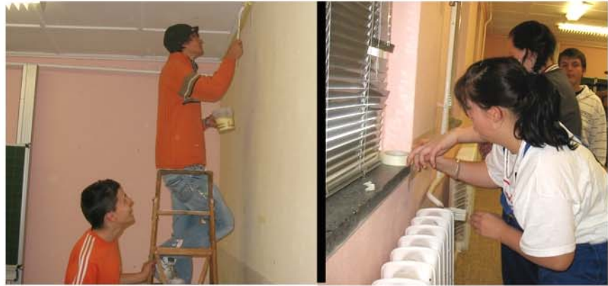
Malerarbeiten in der Schule. Vor dem ersten Farbauftrag muss natürlich abgeklebt werden.
